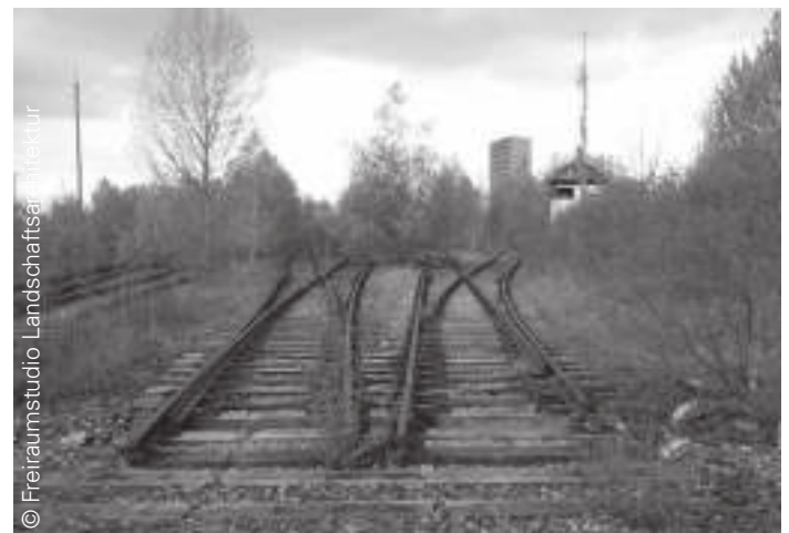
ehemaliges Bahngelände Baumkirchen
